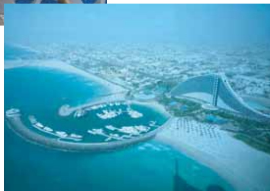
砂浜から 280m 離れた人工島で 本土とは橋でつながっています
